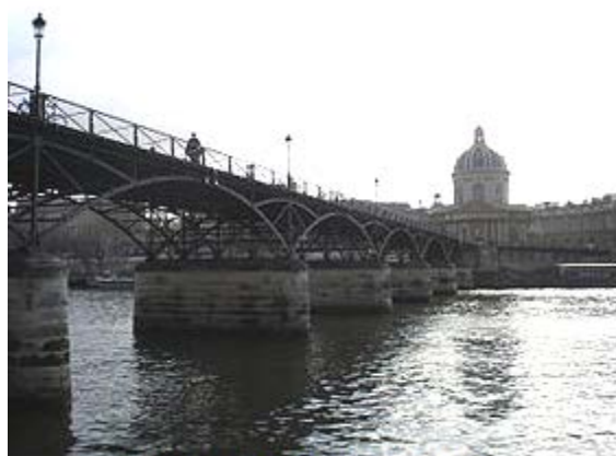
Le pont des Arts et l'Institut de France
